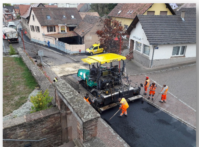
Rabotage de la route et pose d'enrobés centre du village le 25 octobre 2018
